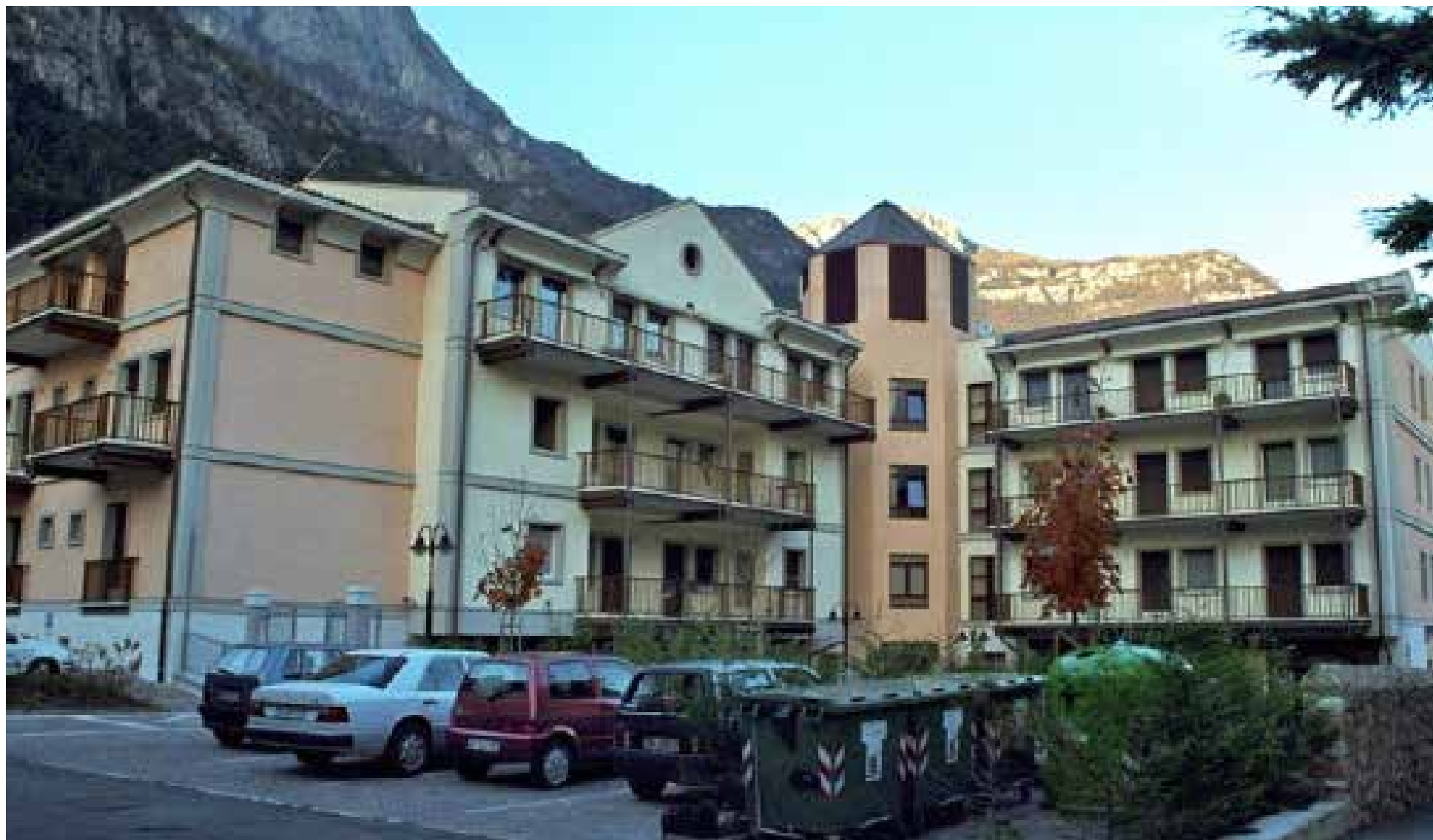
Avio (Tn). Residenza sanitaria assistenziale anziani Avio (Tn). Nursing home
