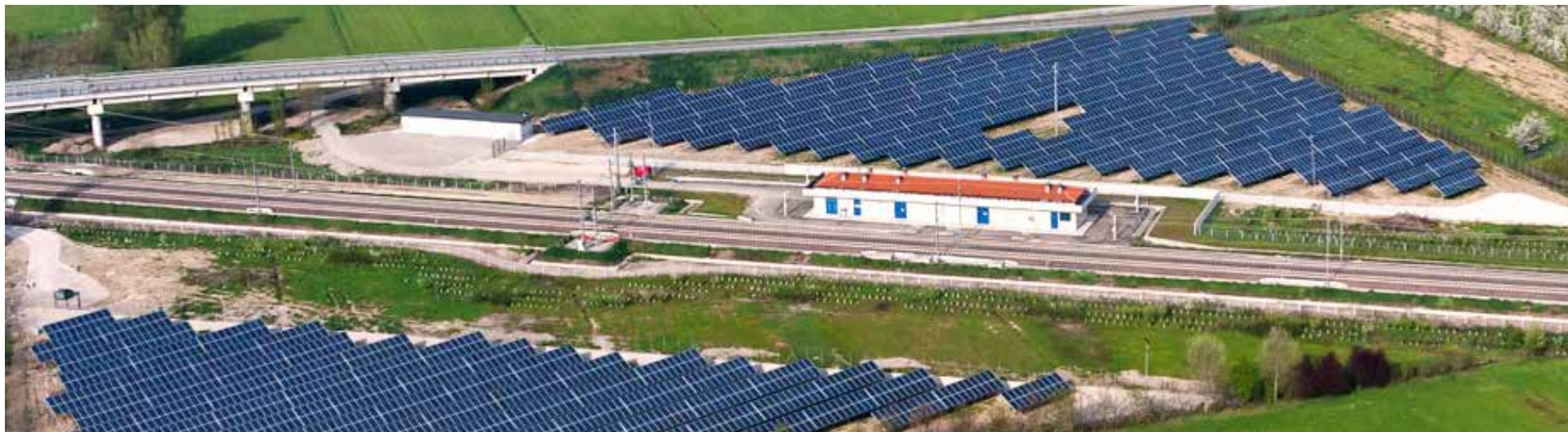
Castelfranco Emilia (Mo). Tre impianti fotovoltaici 0,99 MPW/cad. Castelfranco Emilia (Mo). Development of n. 3 photovoltaic plants unit power 0,99 MPW
